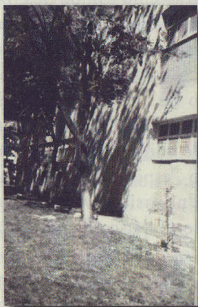
Prédio da Faced – UFC 1991
