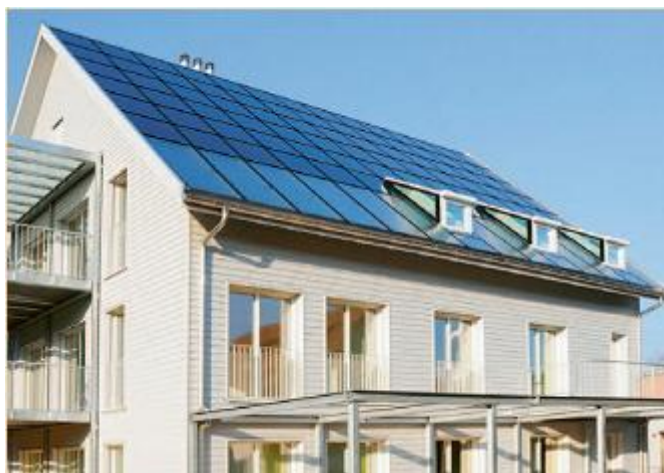
Figura 1.3 – Sistemas fotovoltaico e térmico, combinado em uma casa da Suíça.
