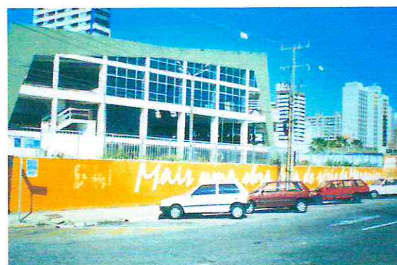
Figura 93 – Clube dos Diários, na Av. Beira-Mar, quando estava prestes a ser demolido para dar lugar a um grande empreendimento imobiliário (foto jul. 2003).
