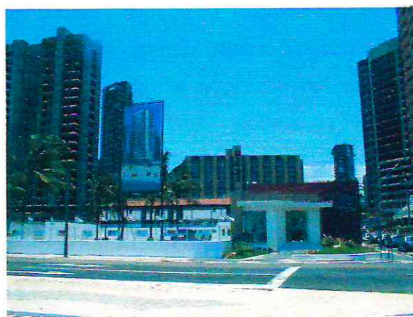
Figura 91 – Terreno do antigo Clube Massapeense, na Av. Historiador Raimundo Girão local onde está sendo construído um empreendimento imobiliário (foto jul. 2003)
