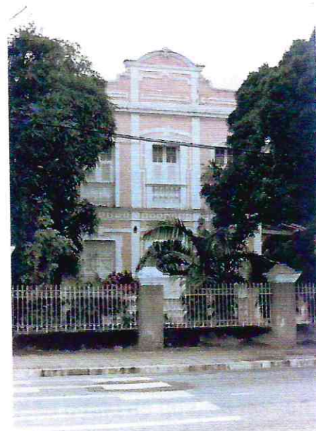
Figura 24 – Exemplar eclético da segunda fase (demolida). Arquivo Beatriz Riedel.
