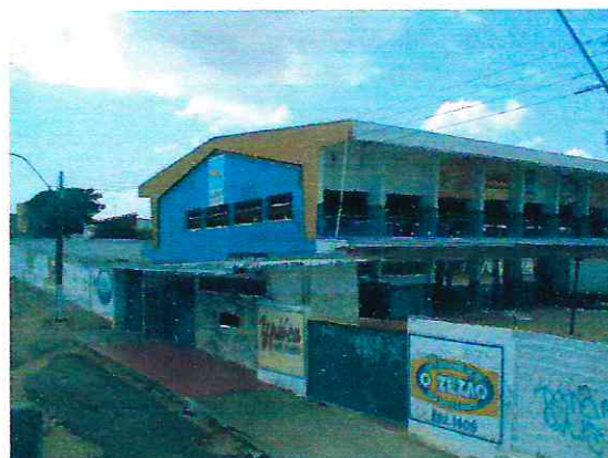
Figura 95 – Antiga sede do Clube de Regatas, na Barra do Ceará, em estado de deterioração e abandono (foto set. 2003).
