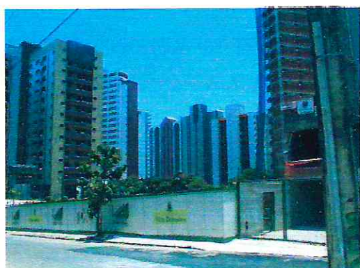
Figura 92 – Terreno onde antes se erguia o Clube Líbano Brasileiro, na rua Tibúrcio Cavalcante atualmente com prédios em construção (foto set. 2003).
