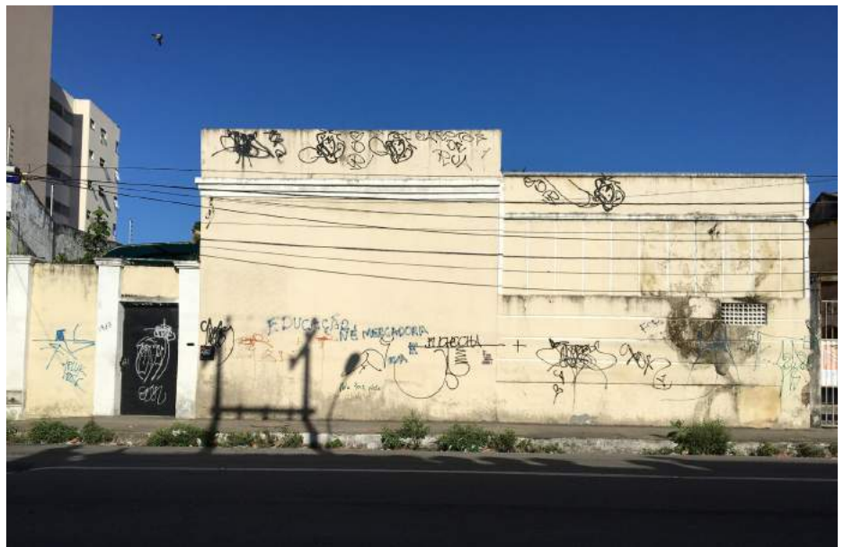
Figura 2.2 Fachada da Residência 2133.
