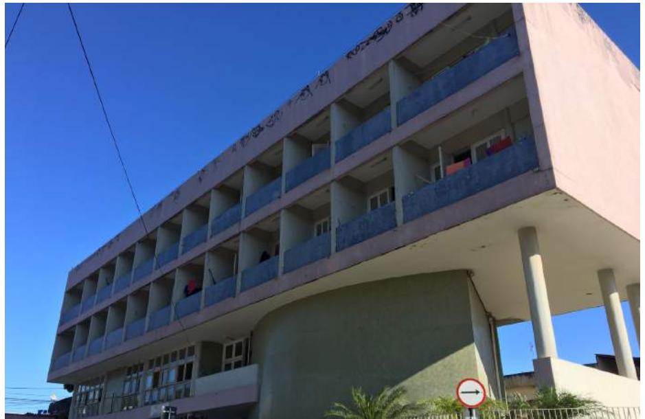
Figuras 2.1 Fachada da Residência 125.
