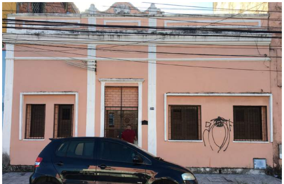
Figura 2.3 Fachada da Residência 2216.
