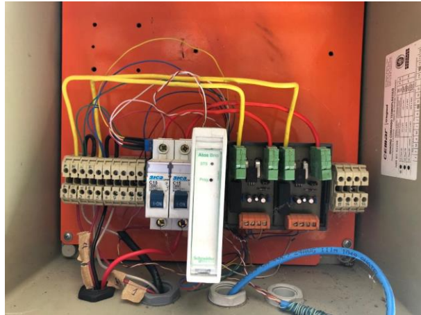
Figura 4.6 – Sensor de corrente conectado ao módulo remoto
