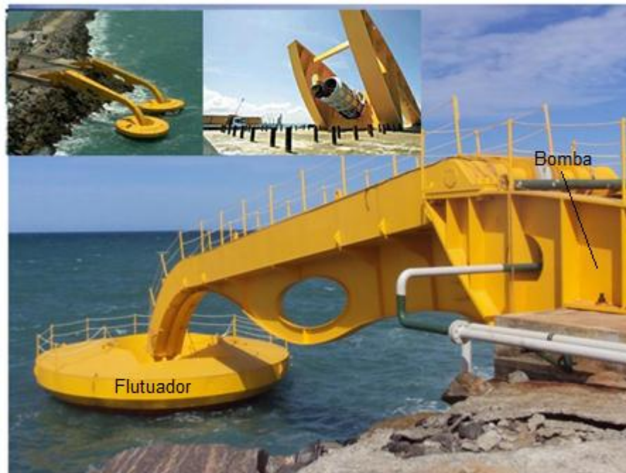
Figura 8: Visão geral dos flutuadores do conversor da COPPE/UFRJ.
