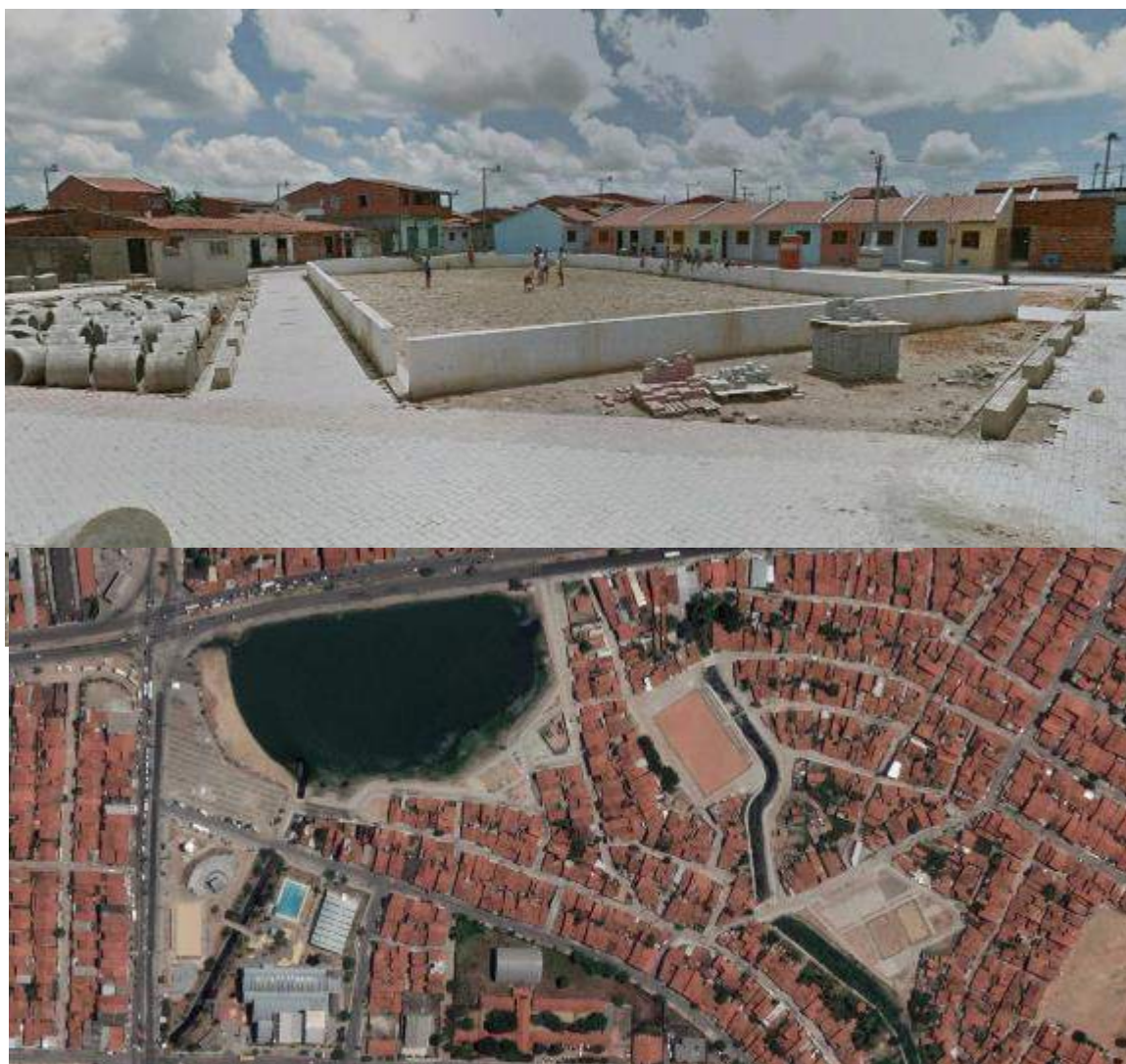
Figura 42 - Obras praça Sítio São Cristovão com melhorias habitacionais ao fundo (2012) e intervenções no Campo Estrela
