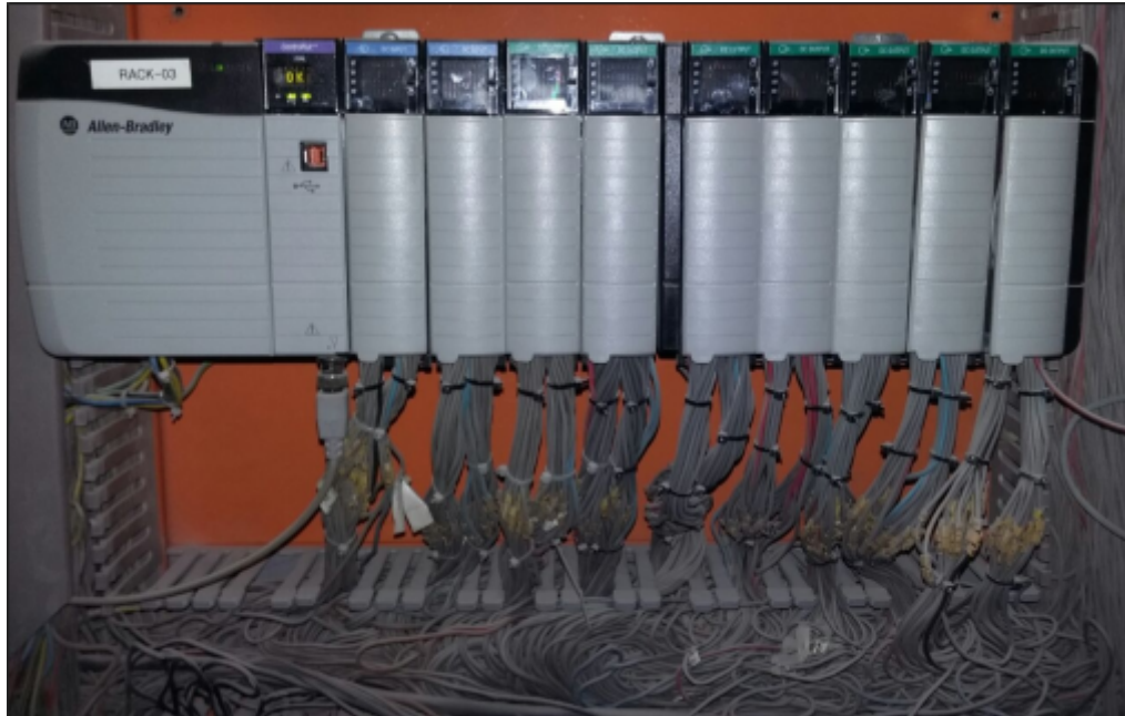
Figura 15 - Chassi três com entradas e saídas digitais.
