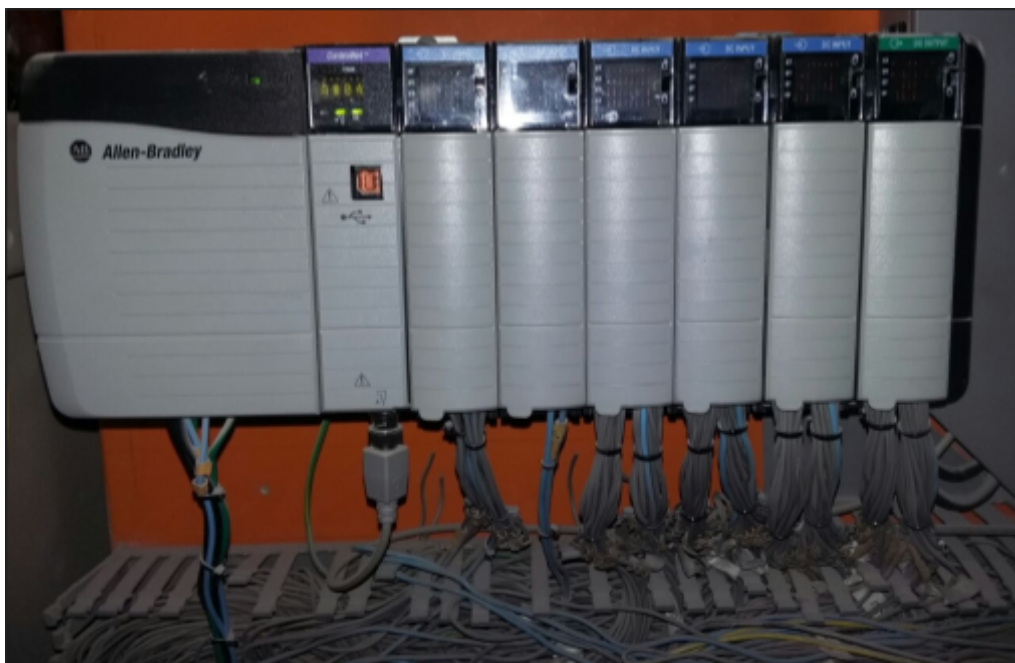
Figura 16 - Chassi quatro com entradas e saídas digitais.
