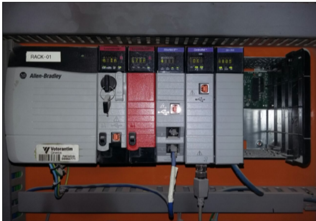
Figura 13 - Chassi um com CPU e cartões de comunicação.
