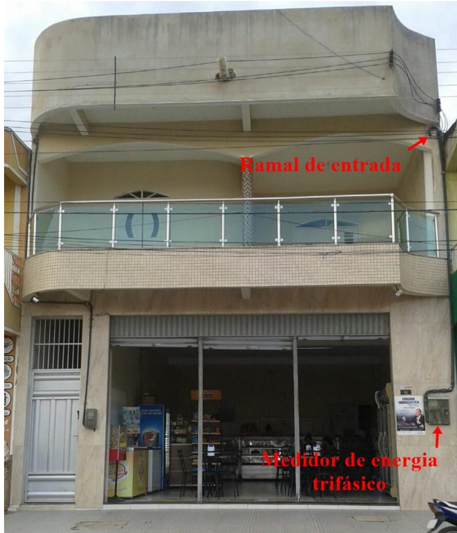
Figura 31 - Fachada do estabelecimento sinalizando o ramal de entrada e a medição
