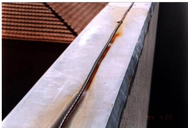
Figura 17 - Cabos deteriorados
