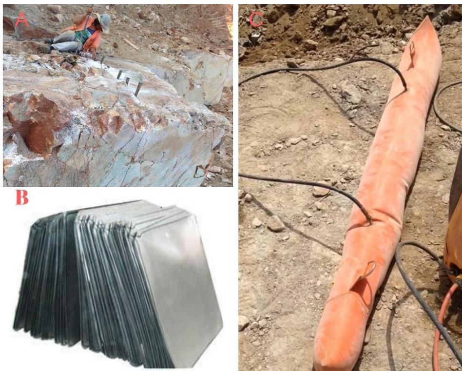
Figura 64 – a) Posicionamento das guias na bancada para abertura de espaço na bancada; b) Hidro bag ; c) Air pillow.
