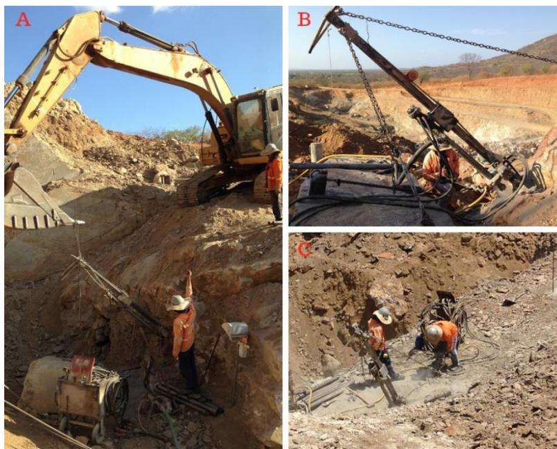
Figura 61 – a) Instalação do fundo-furo com ajuda da retroscavadeira; b e c) Fundo-furo perfurando as bancadas para posterior corte com fio diamantado.
