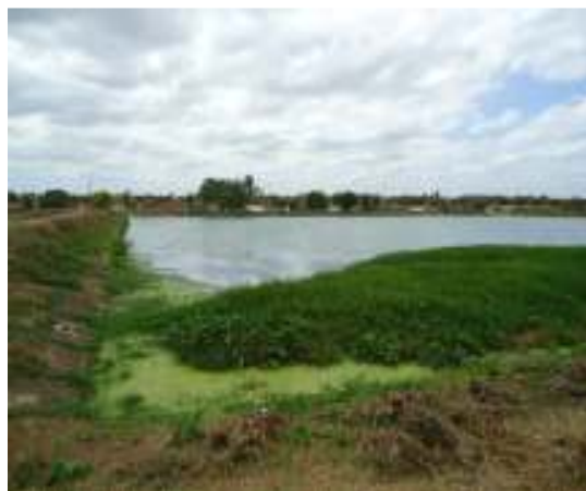
Figura 34 – Lagoa de Maturação 1 - Palmeiras
