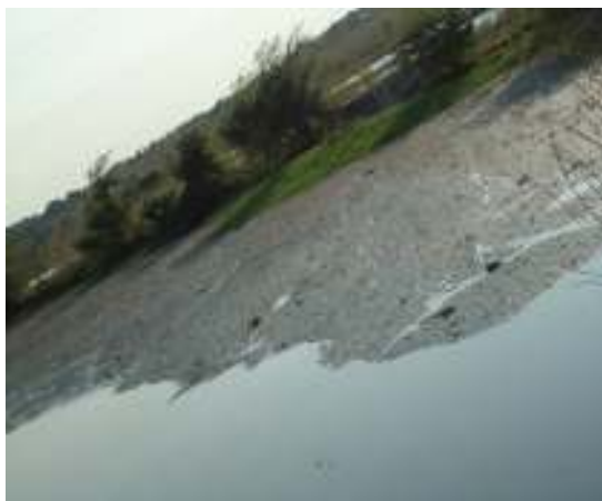
Figura 29 – Escuma na lagoa anaeróbia – Marechal Rondon
