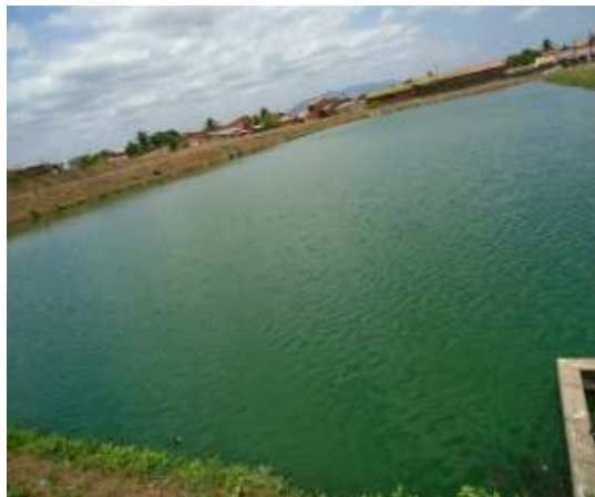
Figura 40 – Lagoa de Maturação – Parque Fluminense
