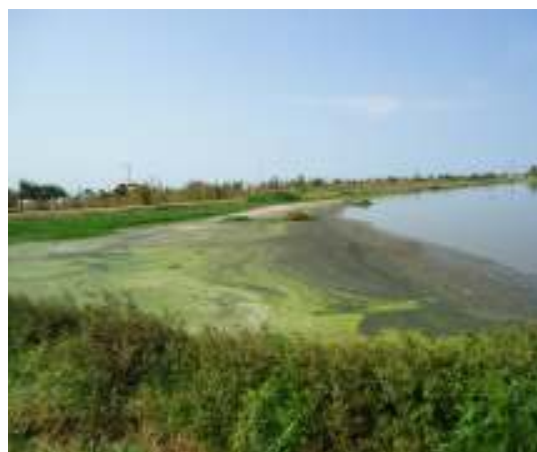
Figura 32 – Vegetação na lagoa facultativa – Nova Metrópole
