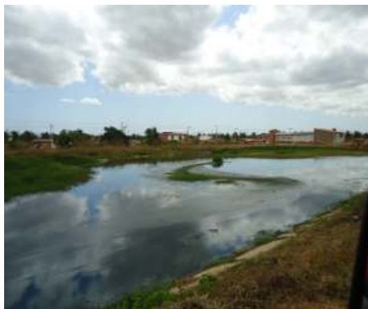
Figura 30 – Assoreamento da Lagoa Anaeróbia - Palmeiras
