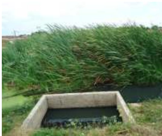
Figura 38 – Vertedouro da Lagoa Anaeróbia – Palmeiras
