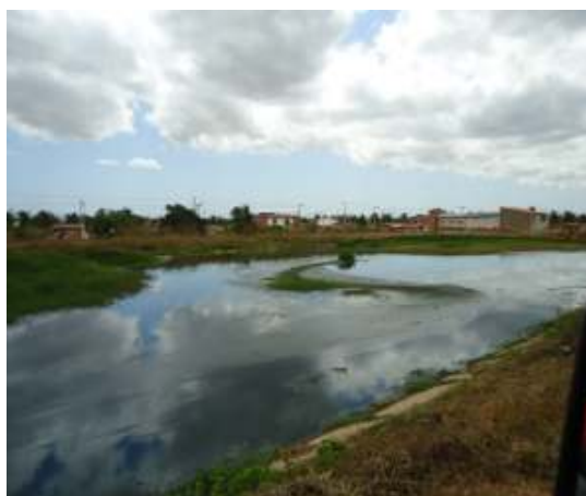
Figura 42 – Assoreamento da Lagoa Anaeróbia - Palmeiras
