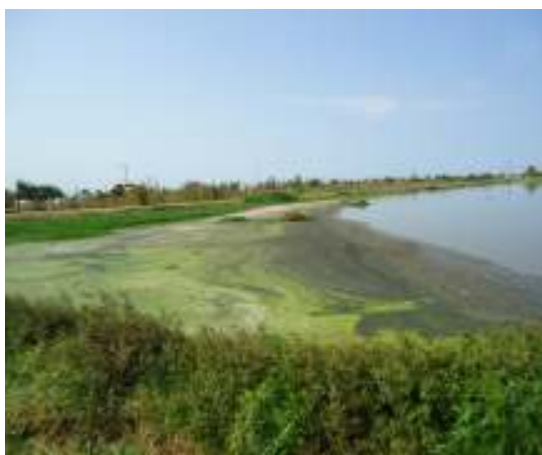
Figura 41 – Assoreamento na lagoa facultativa – Nova Metrópole
