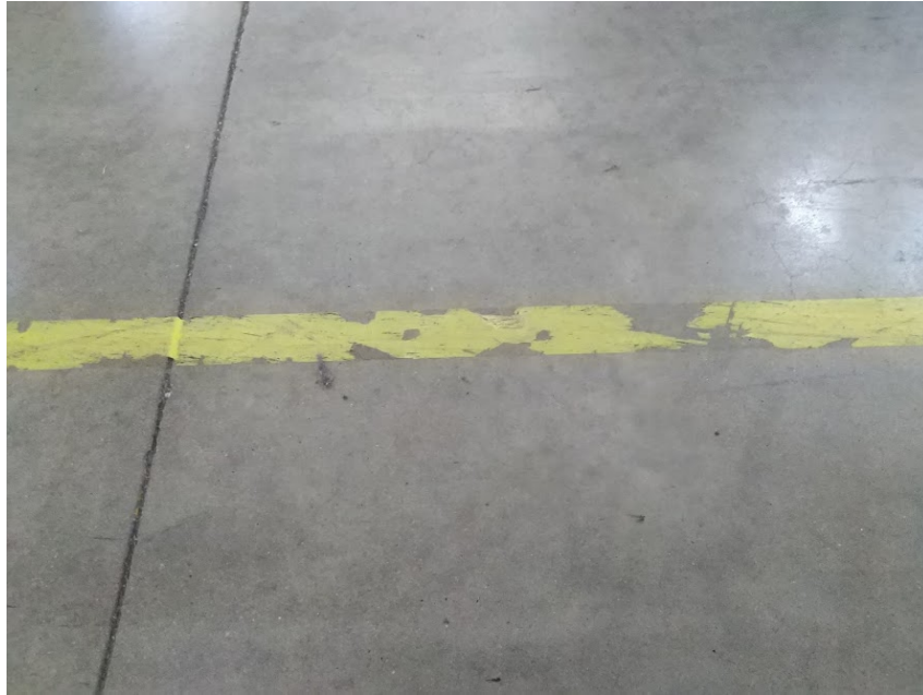
Figura 32 – Faixa de navegação do rebocador
