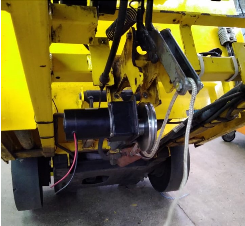
Figura 13 – Instalação do motor para o acionamento do freio
