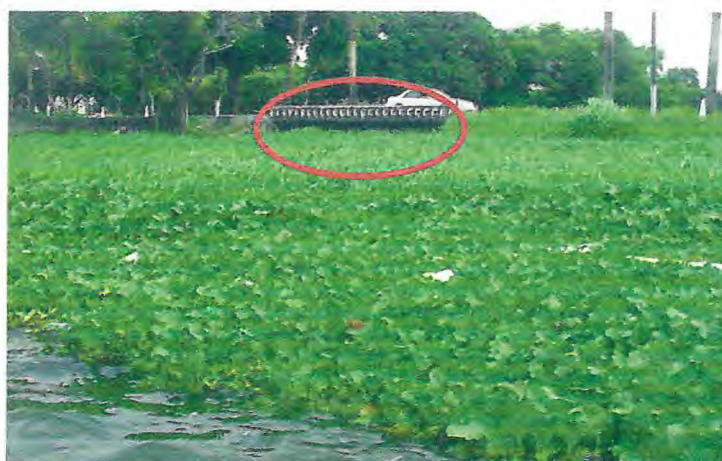
Figura 16 – Visão interna do reservatório destacando o sangradouro e evidenciando as algas e os detritos.
