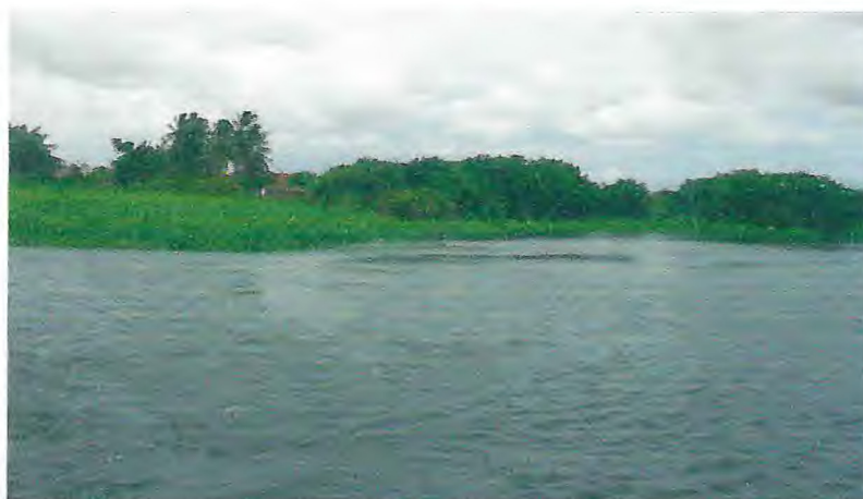
Figura 20 - Montante do açude Santo Anastácio. Porta de entrada de efluentes e sedimentos.
