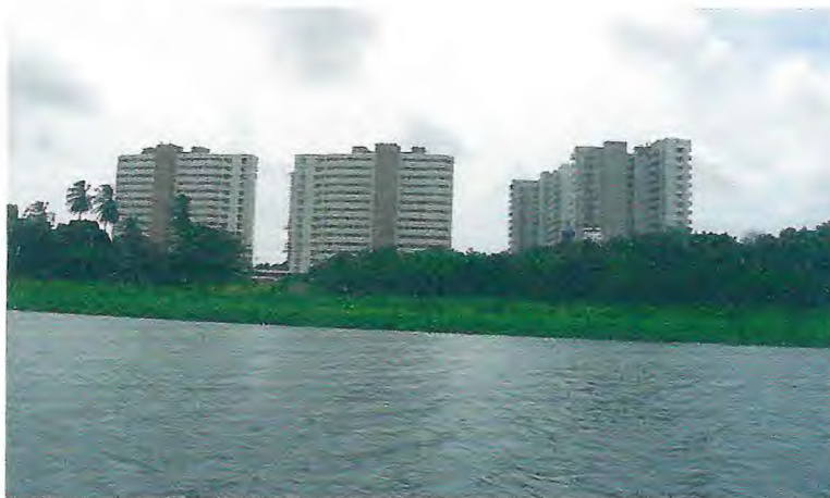
Figura 18 – Condomínios de apartamento em obras próximo ao reservatório.
