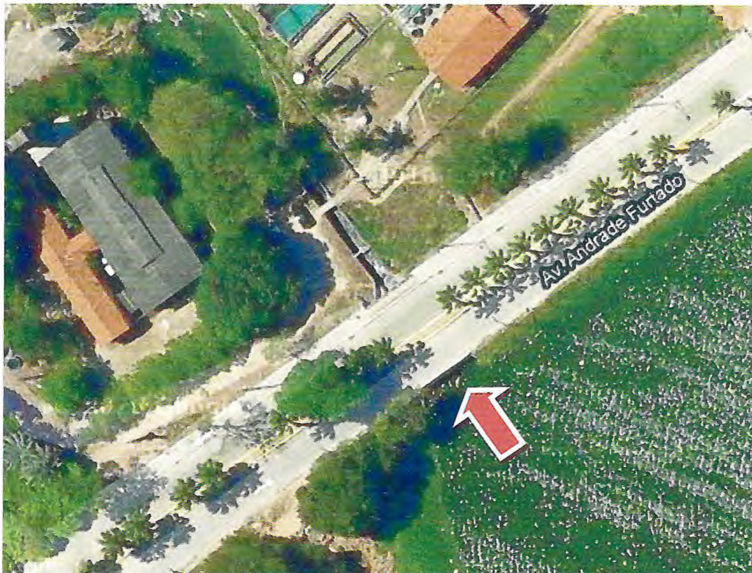
Figura 04 – Visão aérea destacando o sangradouro do açude Santo Anastácio. Fonte: Imagem de satélite, Google Earth. 2011
