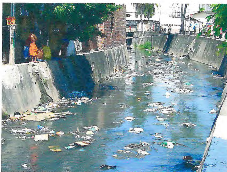
Figura 07 – Despejo de esgotos domésticos e lixo no canal de ligação da lagoa de Parangaba com o açude Santo Anastácio.
