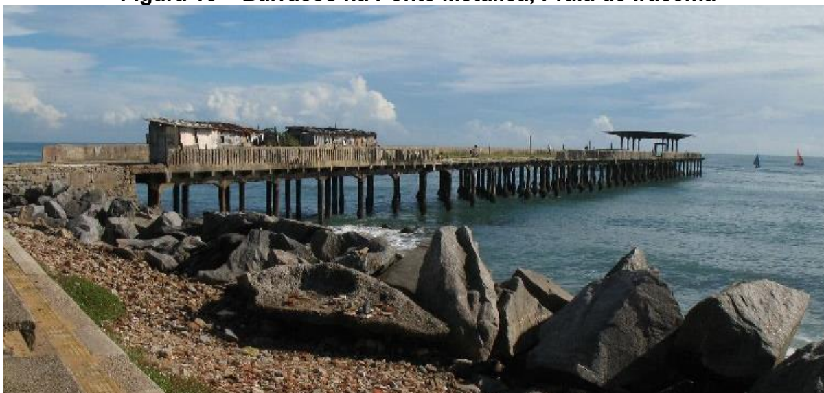
Figura 13 – Barracos na Ponte Metálica, Praia de Iracema
