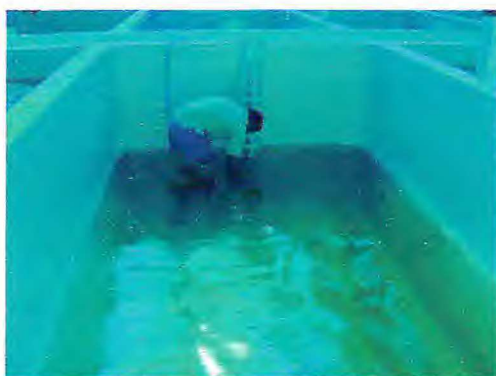
Figura 36 – Detalhe de sifonamento de tanque de fase I.
