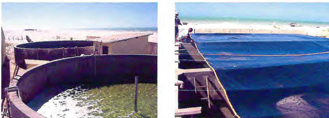
Figura 6 – Reservatórios e casa de bomba. Reservatórios coberto com lona.
