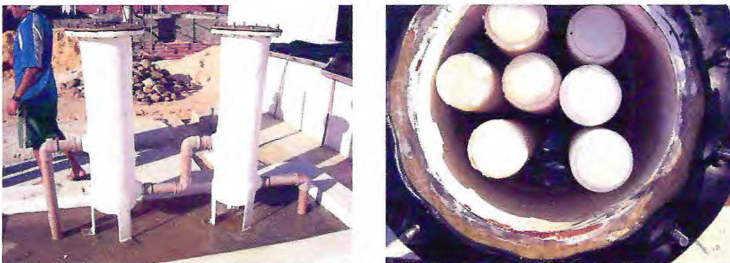
Figura 8 - Filtros de cartuchos e disposição dos cartuchos na carcaça de fibra de vidro.
