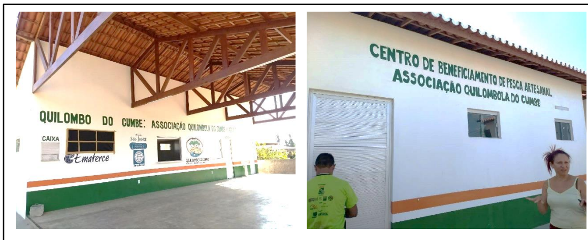
Figura 32 – Construção da estrutura da Associação Quilombola do Cumbe e do Centro de Beneficiamento da Pesca Artesanal.
