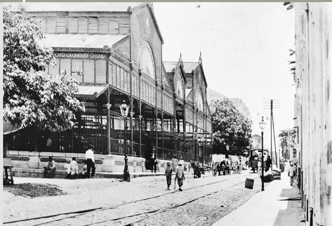
Mercado da Carne, Fortaleza. Fonte: Mercado de Ferro: Notas sobre a restauração do mercado dos pinhões
