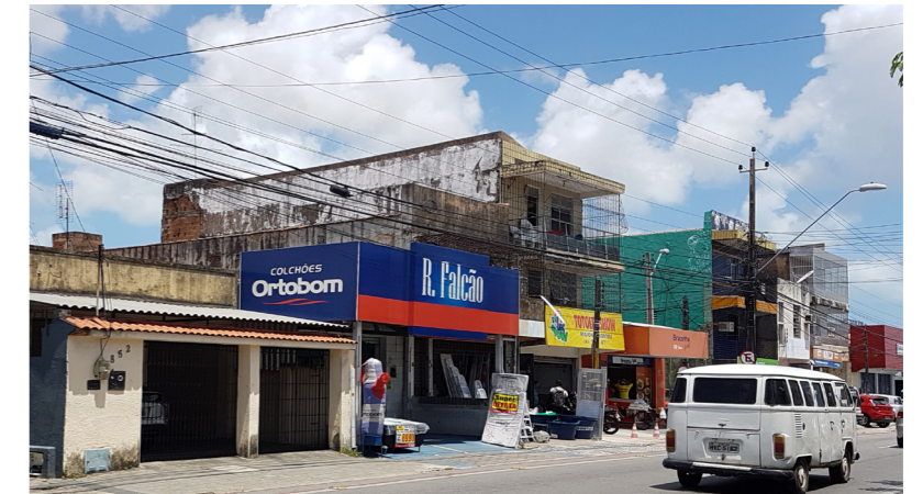
Fig. 4.5.8 - Desordenamento de fachadas na Av. Gomes de Matos Fonte: Arquivo da autora.
