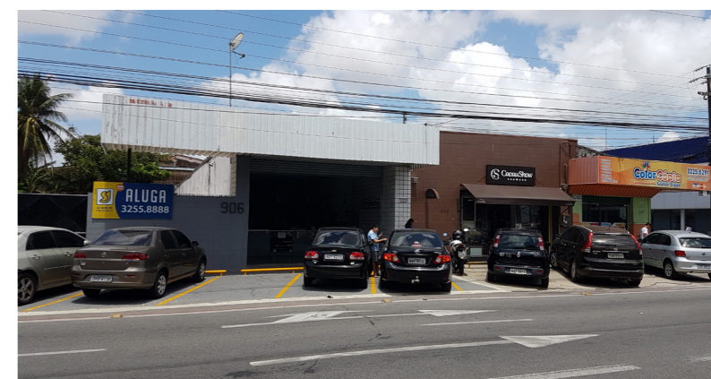
Fig. 4.5.3 - Fachadas pouco convidativas e com muitas barreiras físicas na Avenida Gomes de Matos. Fonte: Arquivo da autora.
