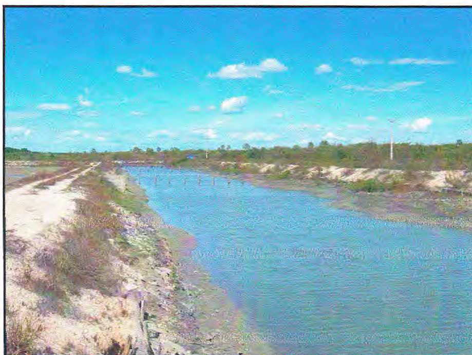
Figura 04 – Vista parcial do canal de abastecimento da Fazenda Picada Nova.
