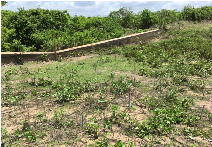
Figura 12 – Instalação dos pinos a montante do vertedouro triangular.
