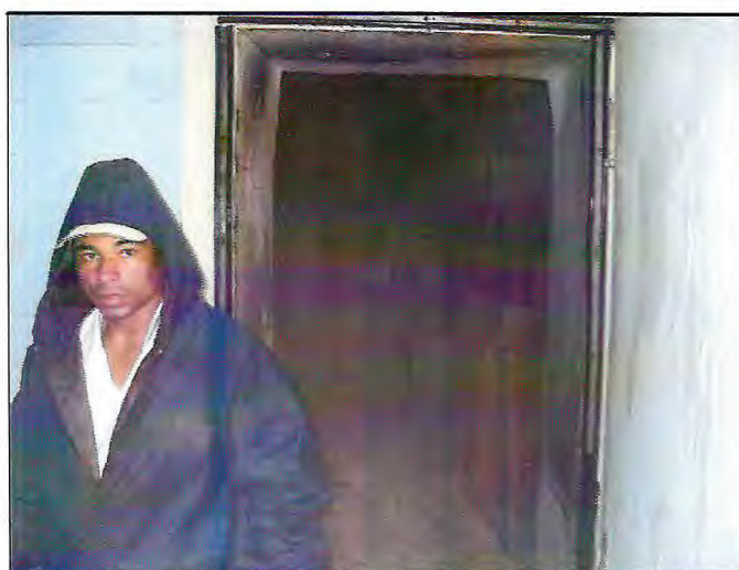
Figura 25 - Funcionário fazendo vistoria na câmara de estocagem da INTERFRIOS – Intercâmbio de Frios S/A, em Fortaleza, Ceará.
