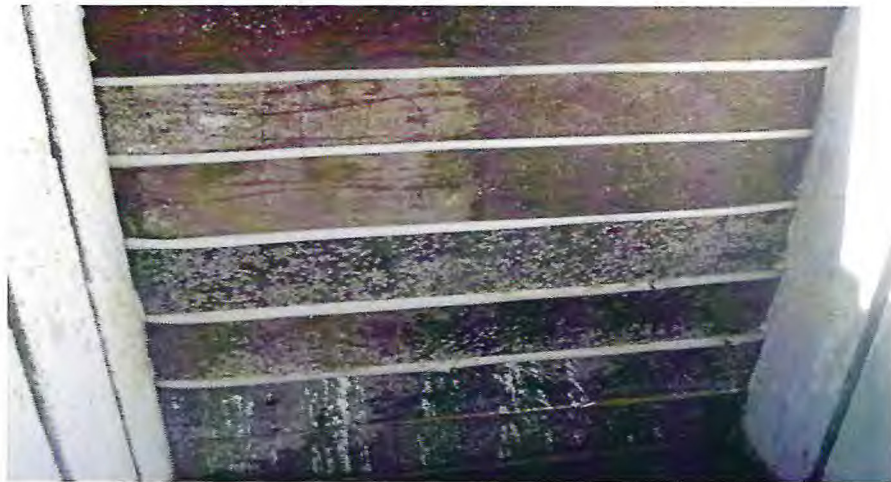
Figura 8- Comporta de drenagem após o fechamento com tábuas e esponjas para melhor vedação do viveiro na BOMAR maricultura. ARAÚJO, 2010
