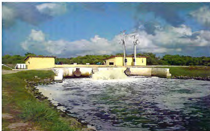
Figura 4 - Casa de bombas em funcionamento pode-se observar parte do início do canal de abastecimento, BOMAR Maricultura ARAÚJO, 2010
