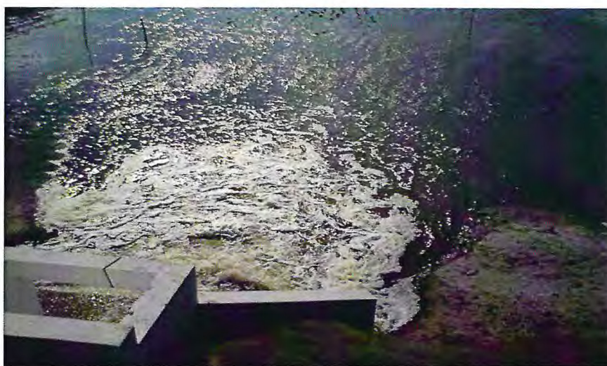
Figura 9 - Abastecimento de um viveiro após a retirada das tábuas superiores da comporta de abastecimento, BOMAR Maricultura. ARAÚJO, 2010.
