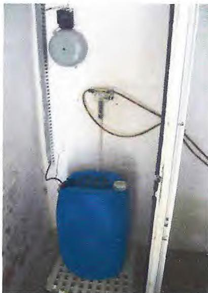
**Figura 4** – Dosador automático de cloro, que abastece todas as caixas d'água da INTERFRIOS.
