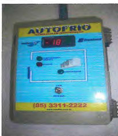
**Figura 7** – Registrador digital de temperatura no interior da câmara de estocagem da INTERFRIOS.
