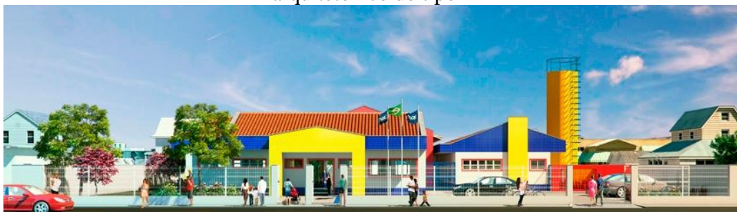
FOTO 1 – Fachada principal de uma instituição do Proinfância conforme projeto arquitetônico do tipo B
