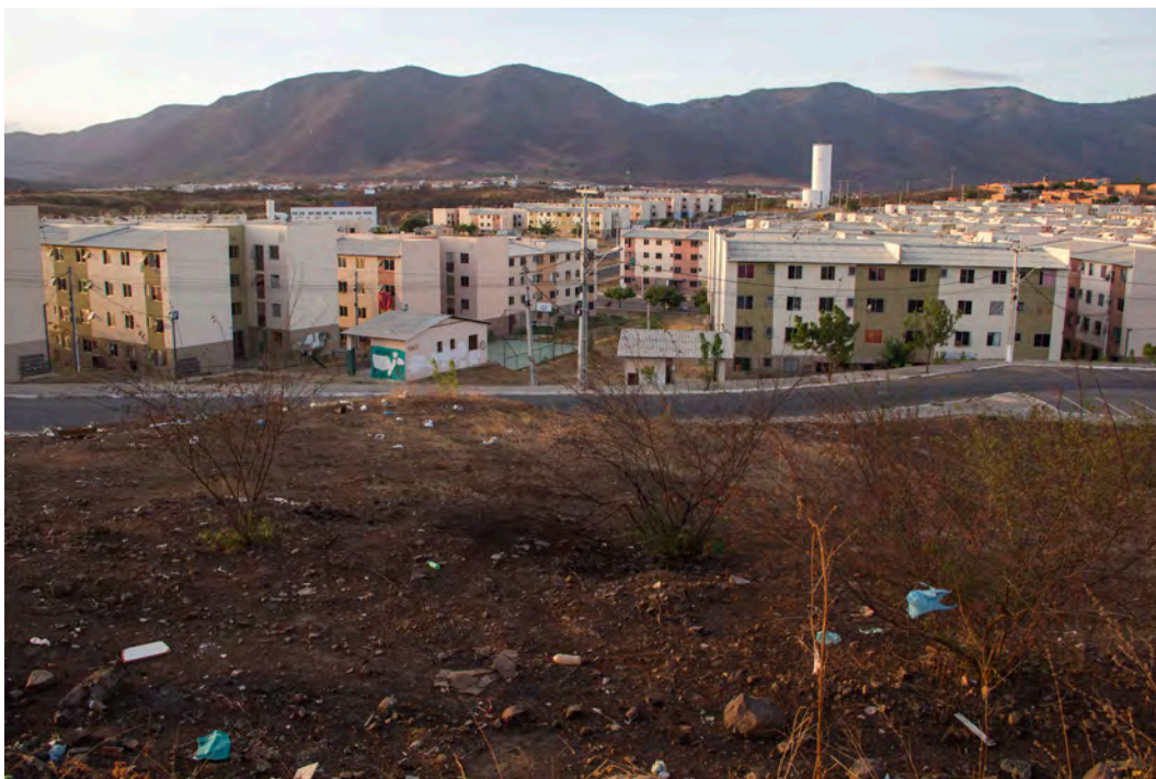
FIGURA 60 Vista ampla do conjunto habitacional Novo Caiçara – grandes distâncias e implantação esparsa que favorecem a sensação de vulnerabilidade no local / Foto: Pedro Cela.
