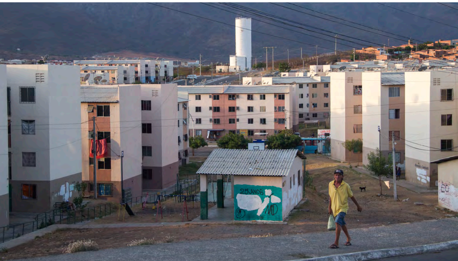
FIGURA 39 Conjunto habitacional Novo Caiçara; ao fundo, a serra da Meruoca / Foto: Pedro Cela.
