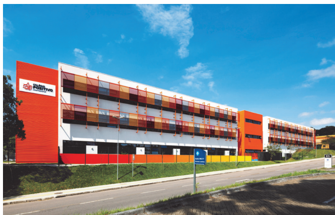
Figura 14. Brises na fachada norte.
