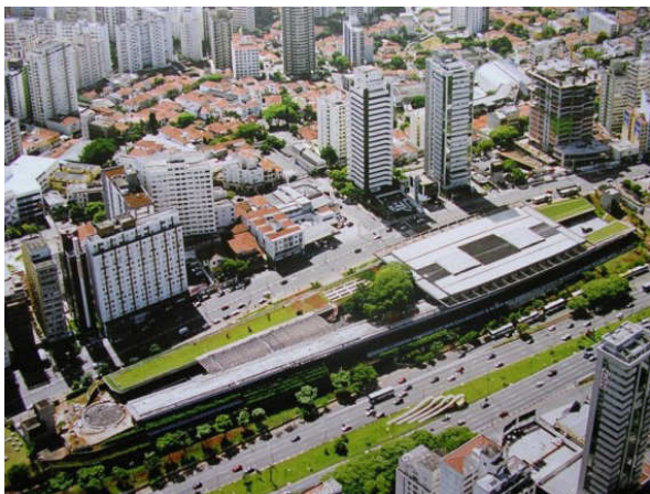
Figura 16: Vista aérea do CCSP. Fonte: <blog.arthurcasas.com/the-city/bienal-de-arquitetura-em-sp>. Acesso em: 13 out. 2013.
