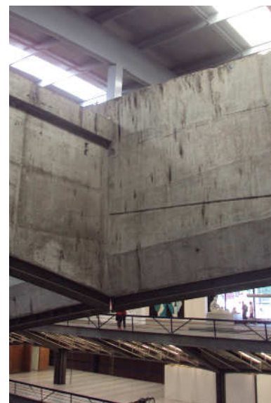
Figura 22: Iluminação natural em fibra de vidro. Fonte: acervo pessoal Renata de Moura.
