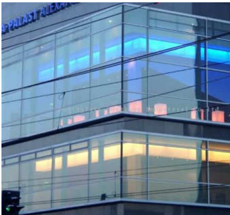
Figura 50: Vidro low-e aplicado em uma fachada de vidro. Fonte: < www.setorvidreiro.com.br >. Acesso em 31 jul. 2013.
