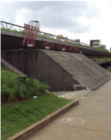
Figura 20: Embasamento da edificação em talude, CCSP. Fonte: acervo pessoal Renata de Moura.
