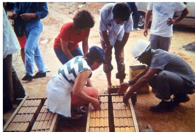
Figura 43 – Instrutor de obra explicando o processo de montagem do painel CPC para moradores de uma comunidade
