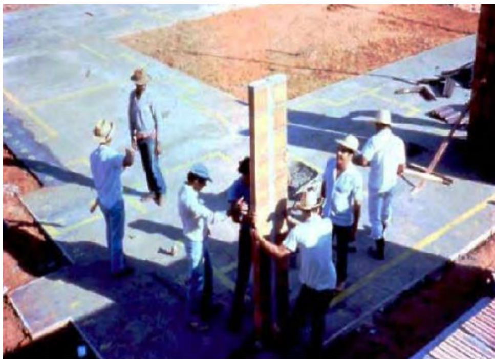
Figura 45 – Montagem de painel CPC sobre radier
