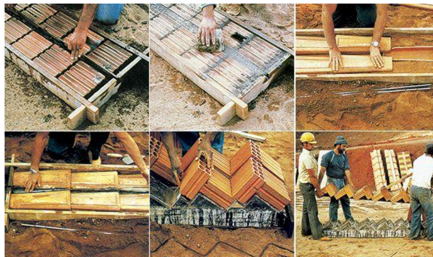
Figura 41 – Finalização de painel CPC em canteiro de obra
