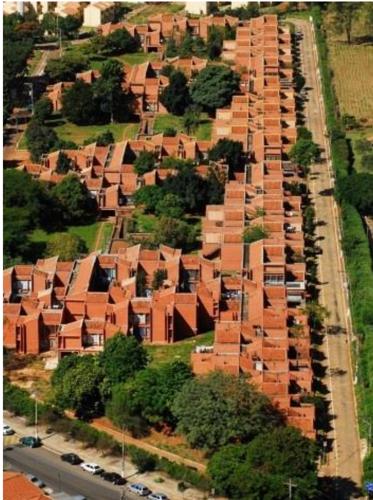
Figura 64 – Residência Estudantil da Unicamp, Campinas
