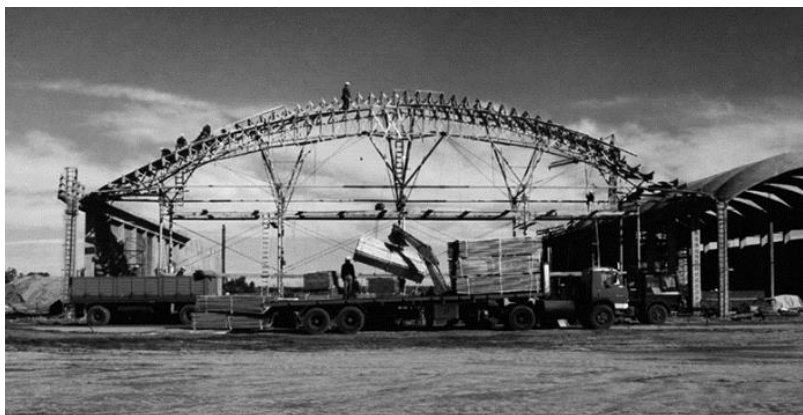
Figura 32 – Fôrmas de madeira e metal construídas para a realização das abóbadas de tijolo
