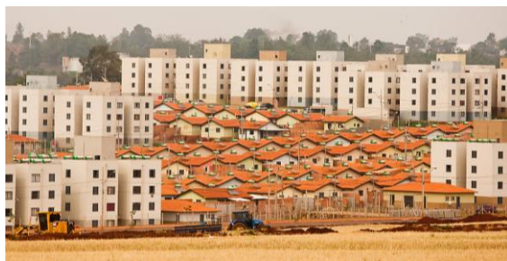
Figura 5 – Obras do MCMV isoladas da malha urbana
