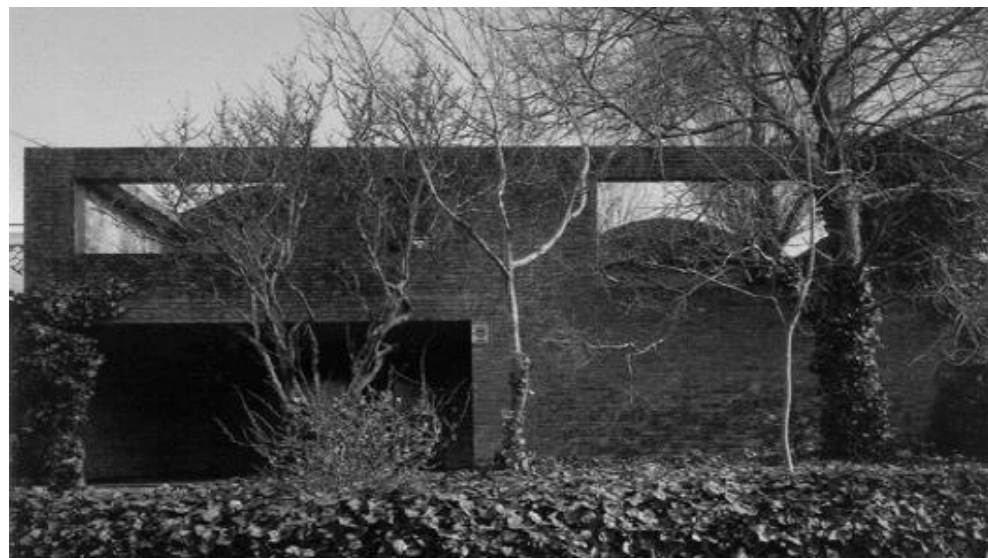
Figura 21 – Vista da casa de Dieste desde o passeio público, Montevidéu, Uruguai (Eladio Dieste, 1960)
