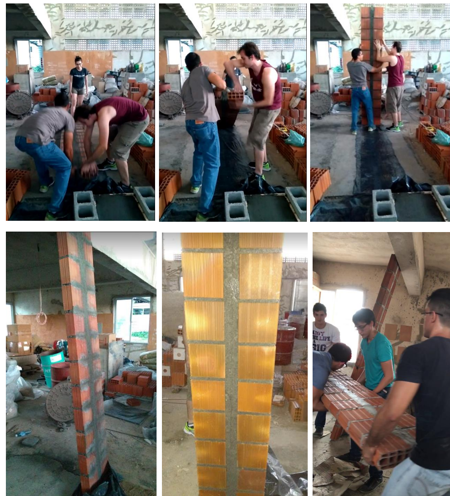
Figuras 74 e 75 – Sequência do içamento do painel CPC construído pelo ETecS (acima, esquerda para direita) e de sua movimentação (abaixo)
