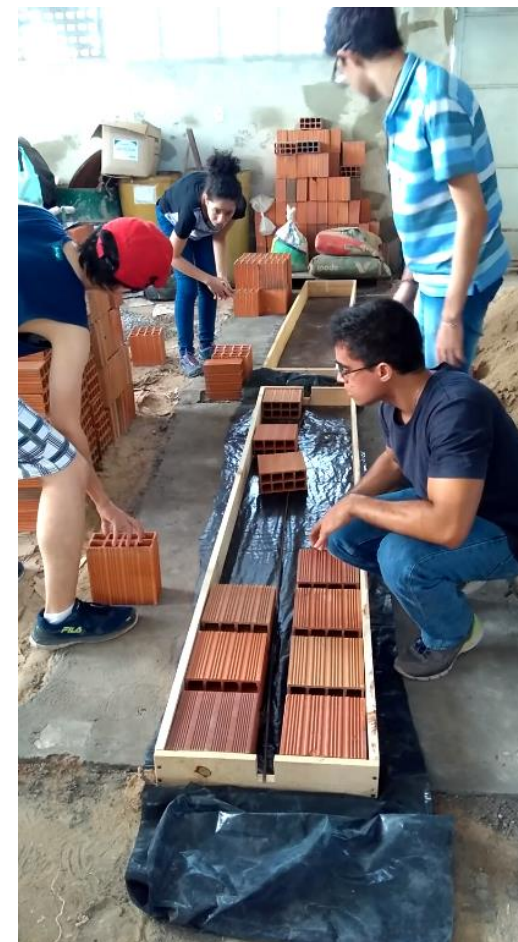
Figura 69 – Montagem dos tijolos do painel pelos integrantes do ETecS, Campus do Pici, Fortaleza, Brasil (2017)
