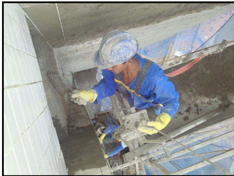
Figura 6 – Aplicação de emboço
