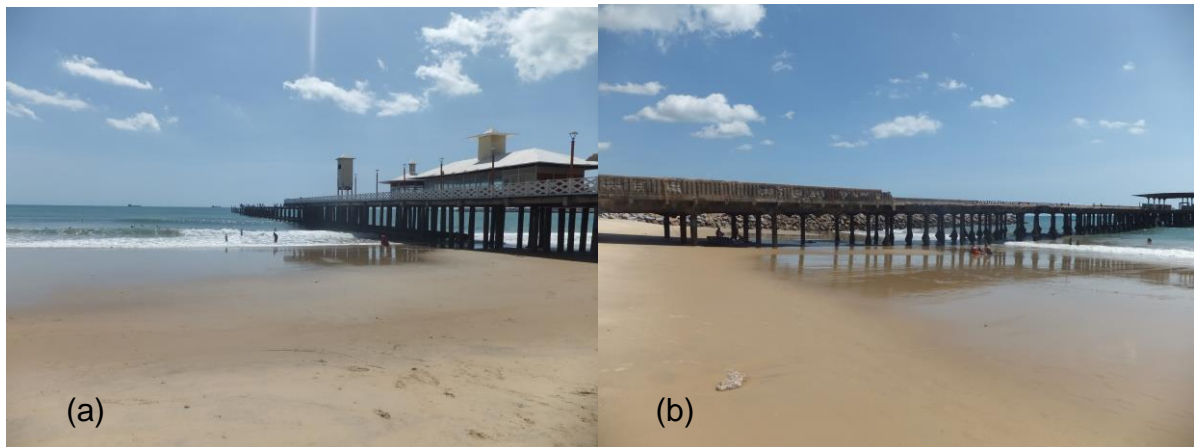
Figura 28: (a) Ponte dos Ingleses localizada no trecho 40. (b) Ponte Velha (antiga Ponte dos Ingleses) localizada no trecho 43. Fonte: Autor.
