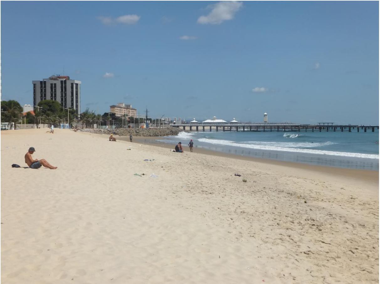
Figura 25: Vista da praia do Aterrinho. Ao fundo a praia deixa de existir para compor obras de contenção à erosão (enrocamento). Fonte: Autor
