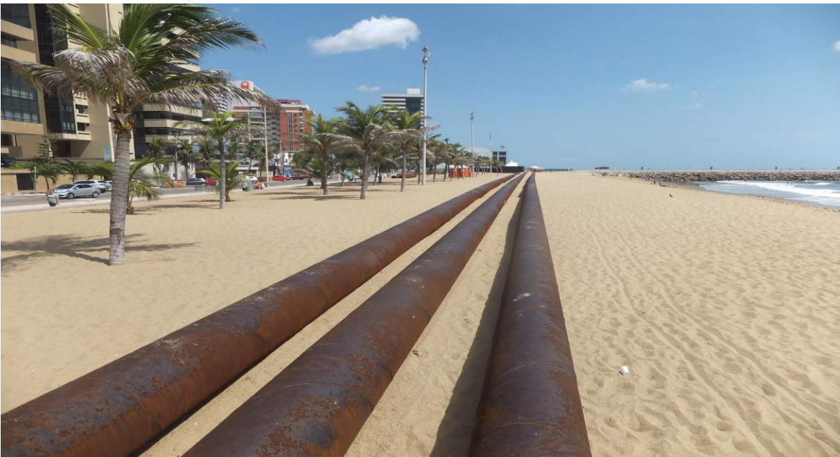
Figura 23: Dutos expostos na pós-praia da área Aterro 2. Fonte: Autor.
