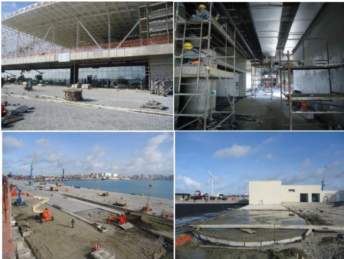
Figura 13: Fotos Novo Terminal Portuário
