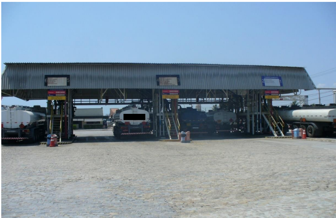
Figura 2 – Plataforma de carregamento de combustíveis
