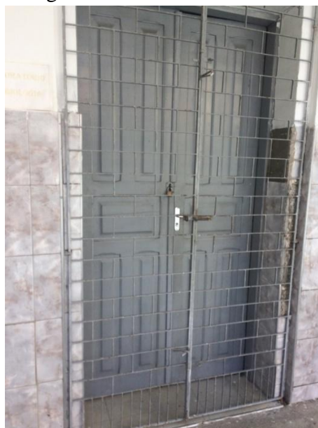
Fotografia 05 – Fachada do Laboratório de Biologia da E2
