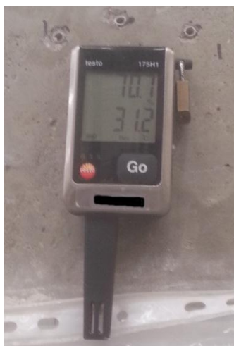
Figura 8 – Um dos data loggers de temperatura e umidade da fábrica
