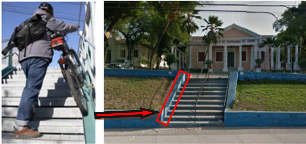
Figura 34 – Canaletas para auxílio do transporte de bicicletas em escadarias
