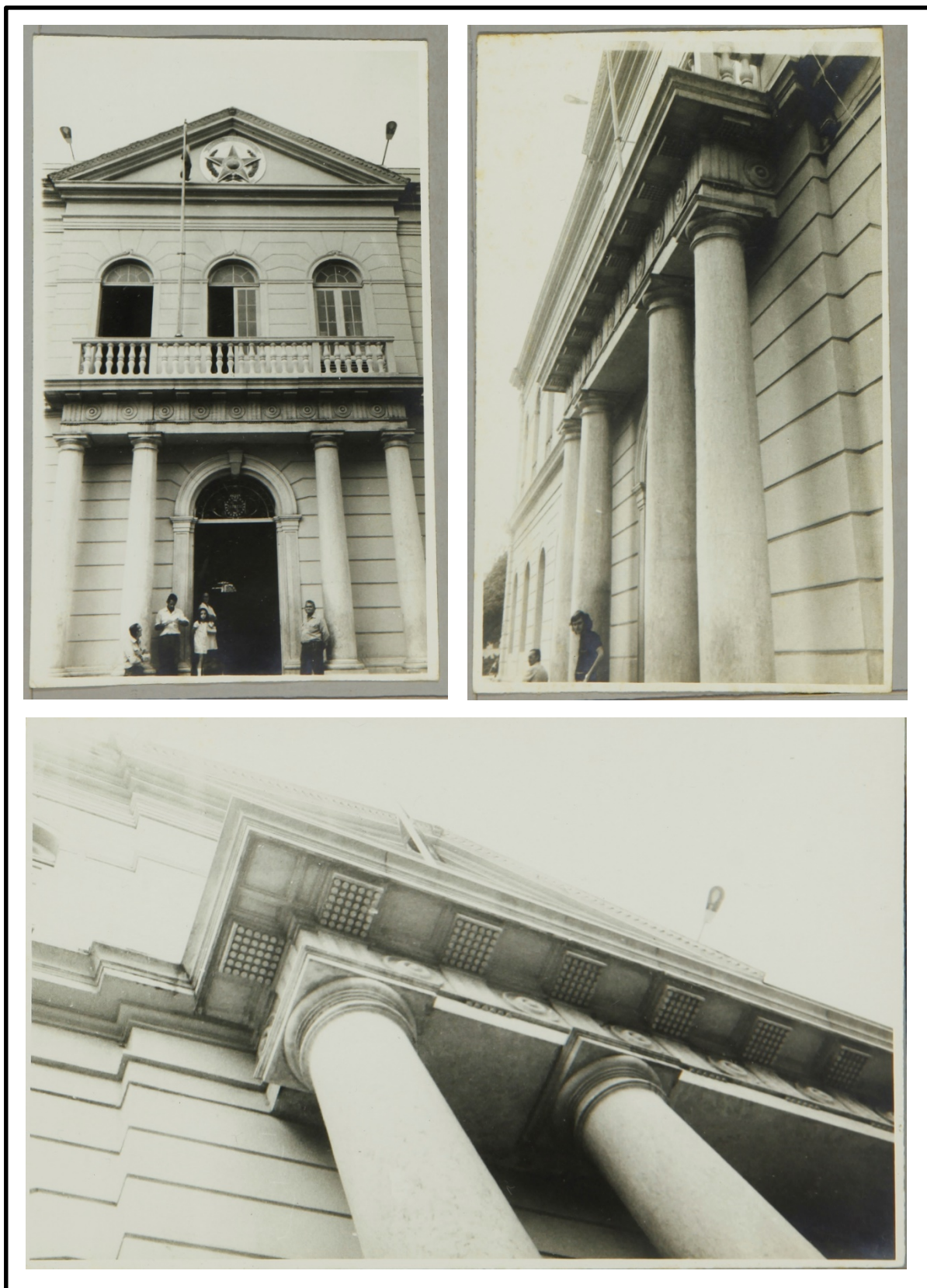
Figura 42: Detalhes da fachada da antiga Câmara Municipal
