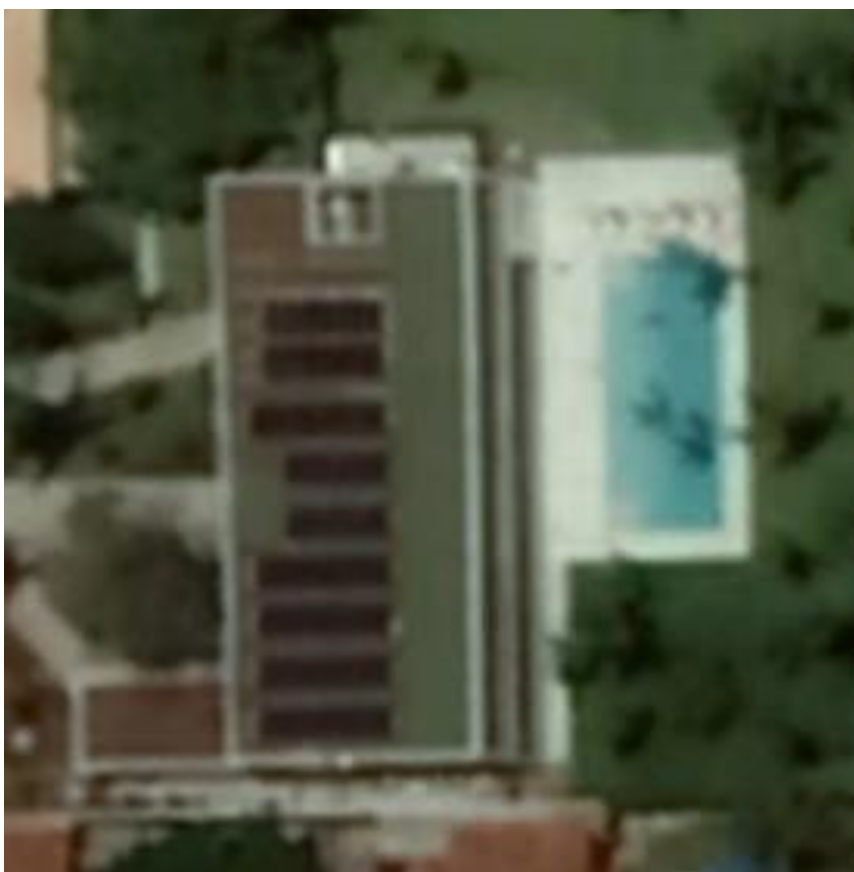
Figura 23: Imagem aérea de sistema fotovoltaico 16,12kW.
