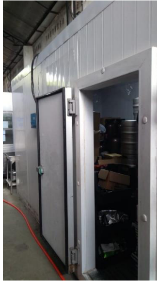
Figura 24 - Câmara de refrigeração para armazenagem de produtos.
