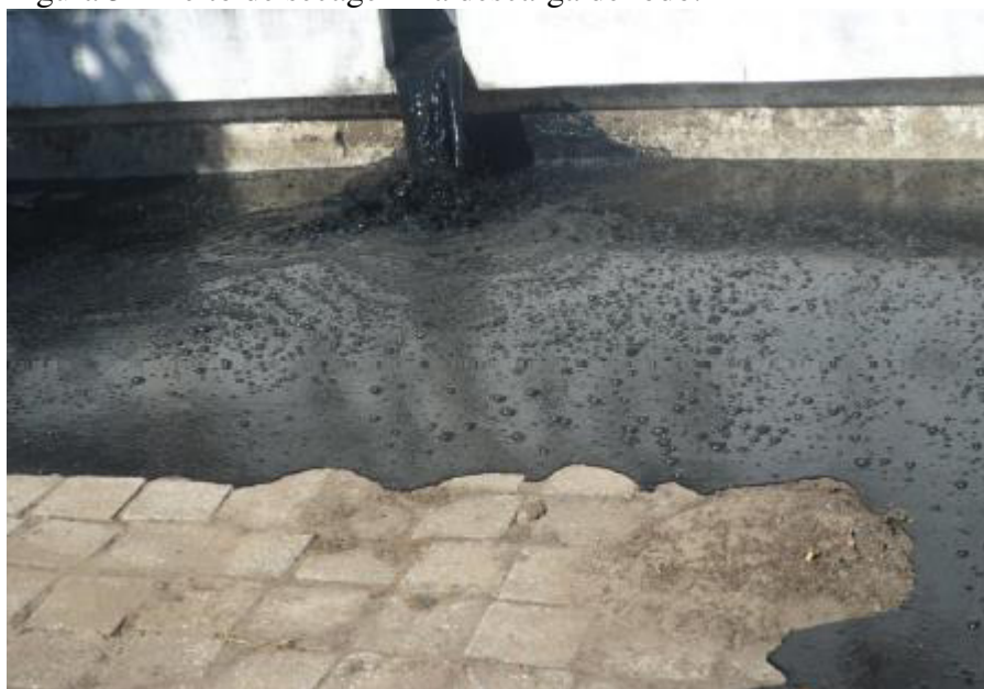
Figura 3 – Leito de secagem na descarga de lodo.
