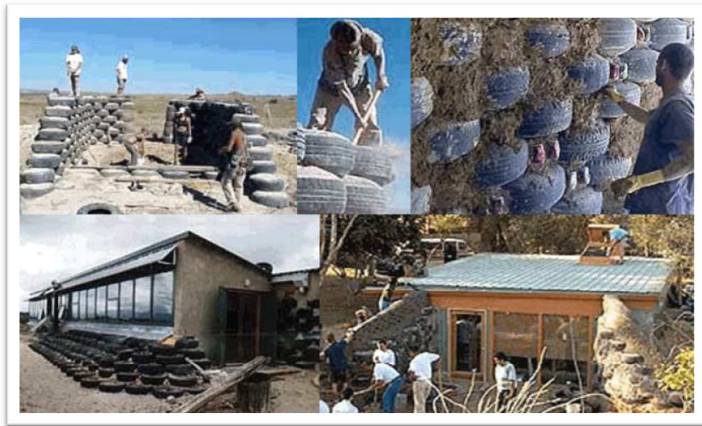
Figura 9 - Construção de Edificações com pneus
