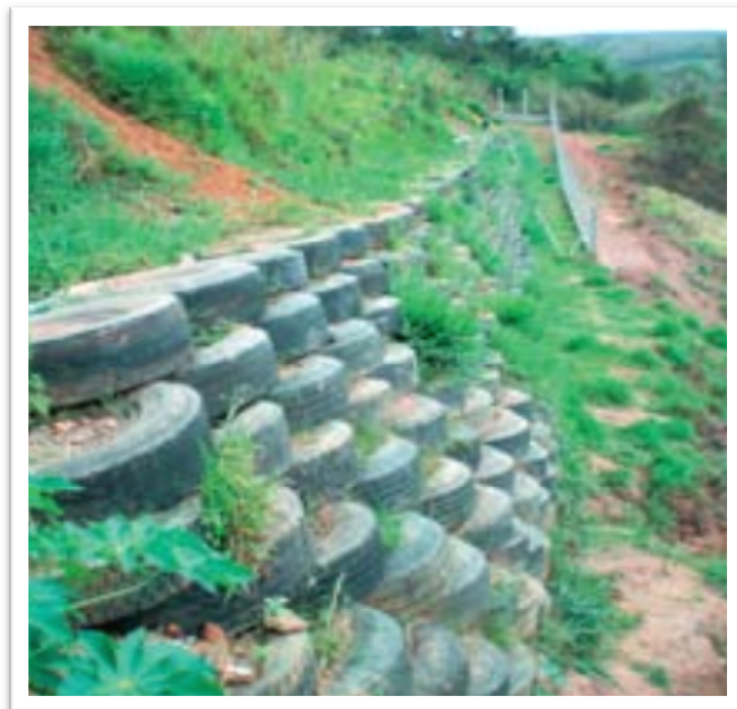
Figura 8 - Muro de contenção com pneus inservíveis
