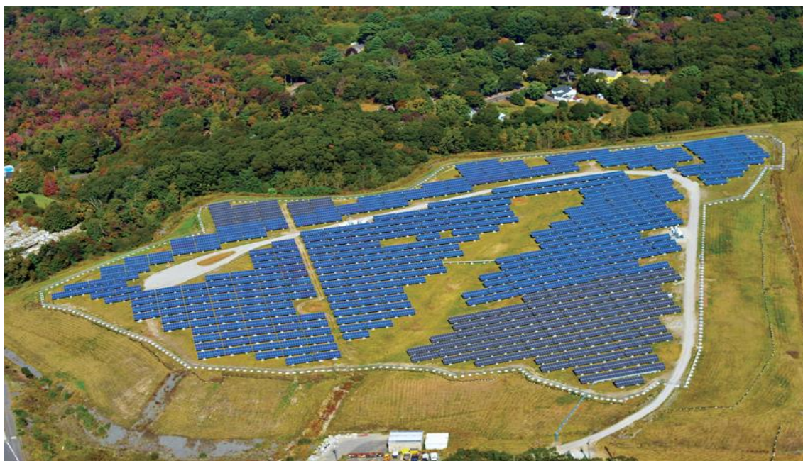
Figura 6 – Aterro solar em Scituate, Estados Unidos. Potência: 3 MW.
