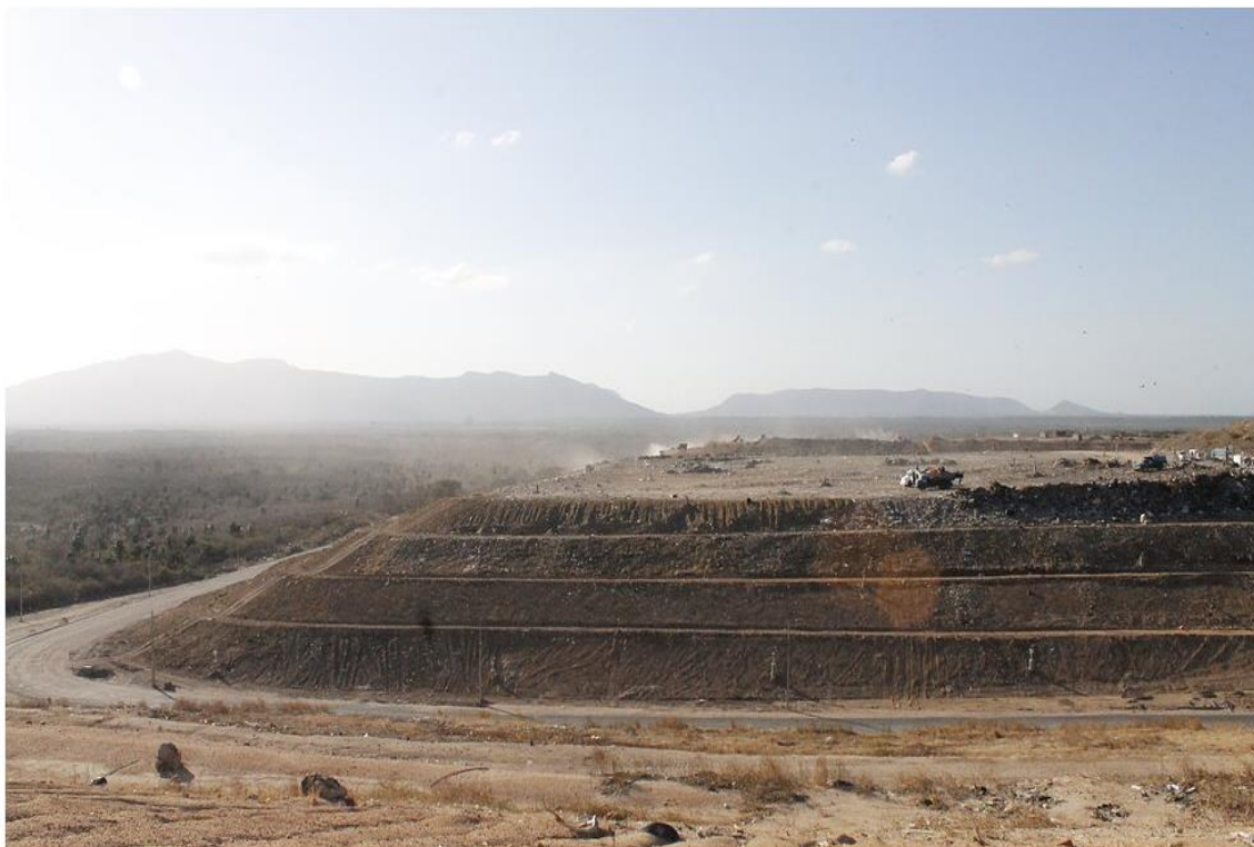
Figura 9 – Vista do Aterro Sanitário Metropolitano Oeste de Caucaia – CE.
