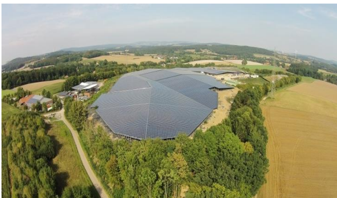
Figura 8 – Aterro solar em Detmold, Alemanha. Potência: 9,78 MW.
