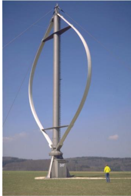
Figura 3 – Aerogerador de eixo vertical
