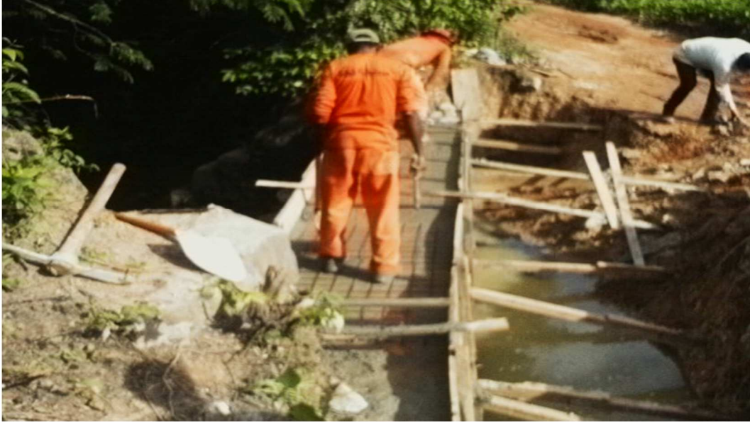
Figura 19- Recuperação da barragem do açude da Viúva
