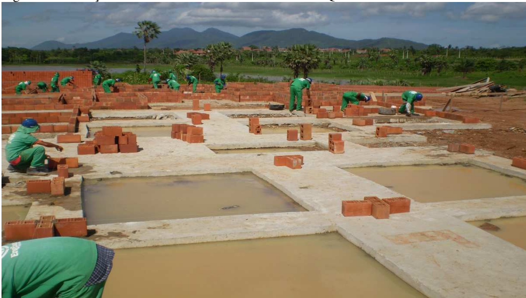
Figura 10- Fundação em alvenaria do Residencial Rachel de Queiroz
