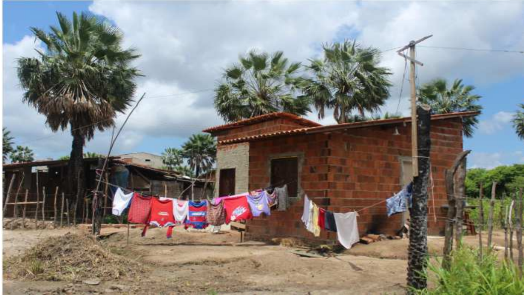
Figura 15- Consolidação de imóveis no interior do PULV (ADA)
