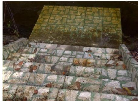
Figura 22.8 – Escada em alvenaria
