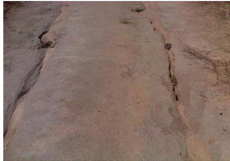
Figura 32.5- Erosão por sulco na estrada de acesso
