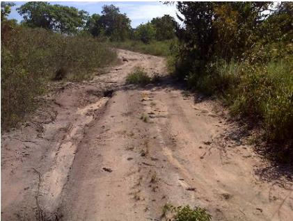
Figura 32.4 – Erosão por sulco na estrada de acesso
