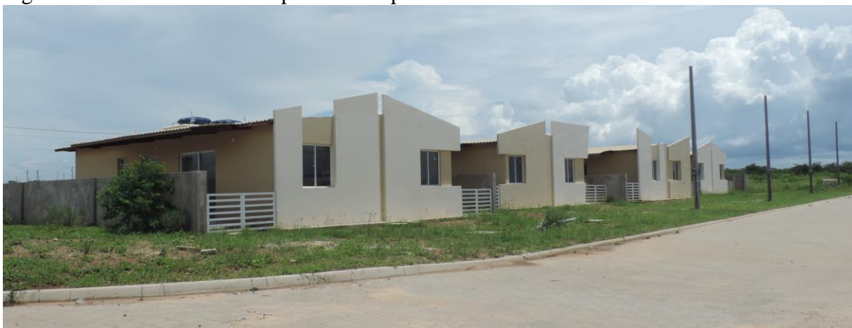
Figura 53 – Casas construídas pela SG Empreendimentos.
