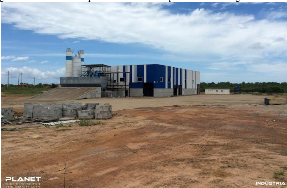
Figura 40 – Indústria de pré-moldados no empreendimento Laguna Smart City
