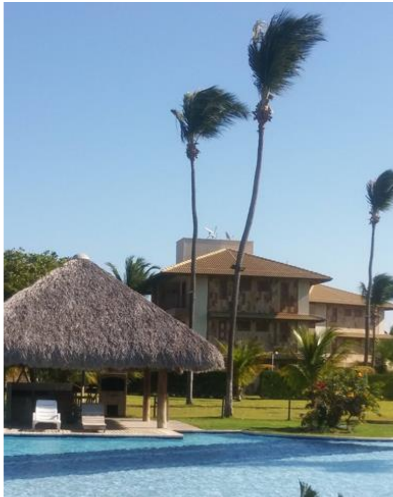
Figura 45 – Condomínio vertical dentro do Condomínio Vila do Porto.
