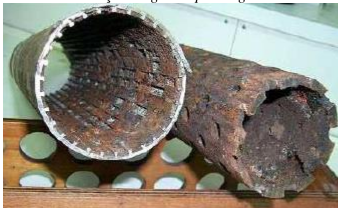
Figura 4 – Severa incrustação no gravel packing .
