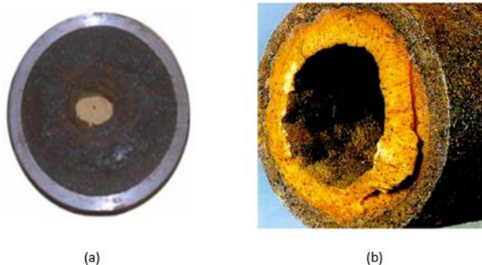
Figura 3 - Depósito de parafina em tubulação.
