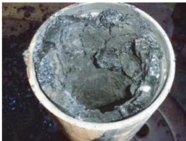
Figura 6 – Depósito de asfaltenos em tubulação.
