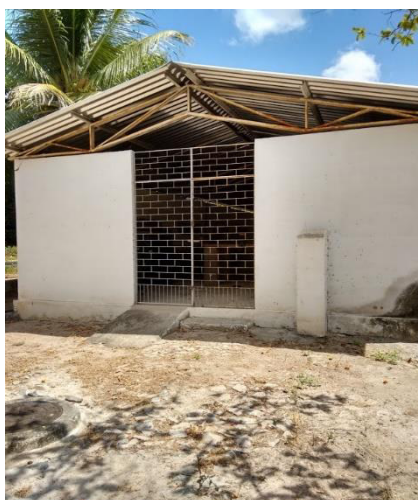
Figura 13 - Local onde os biodigestores foram montados.
