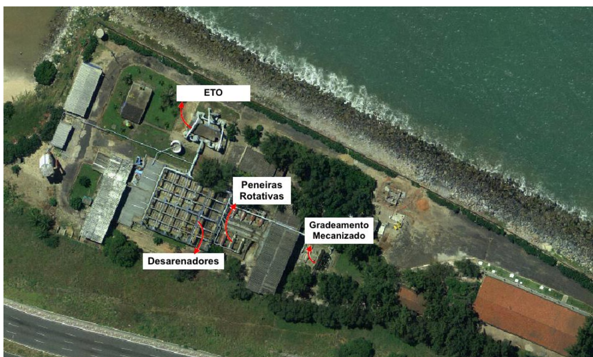
Figura 16 - Estação de pré-condicionamento de esgoto (EPC)
